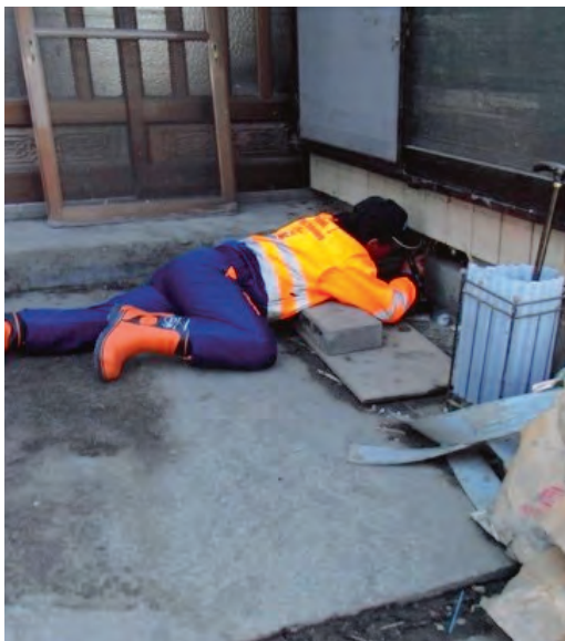
通風口から床下の泥を確認する
