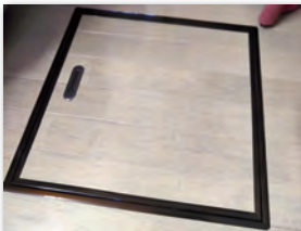
写真④ このような点検口から床下を確認できる
