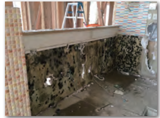
システムキッチンを外した裏側
