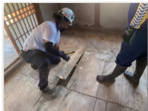
畳を上げ、畳の下の床板をバールなどではがす
