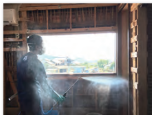
高圧洗浄機で泥を洗い流す
