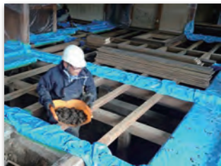
床下の泥をかき出す。必要などころは養生をする
